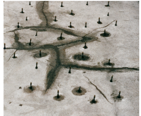
Colmater les fissures et injecter la chape creuse avec PCI Apogel F.
