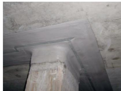
Bande d'étanchéité PCI Pecitape 3000 collée avec PCI Barrafix EP.
