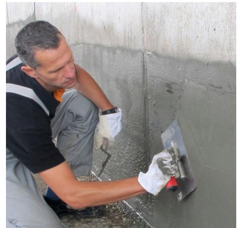
PCI Barraseal est plastique-souple. Les pores et cavités se ferment facilement et rapidement.
