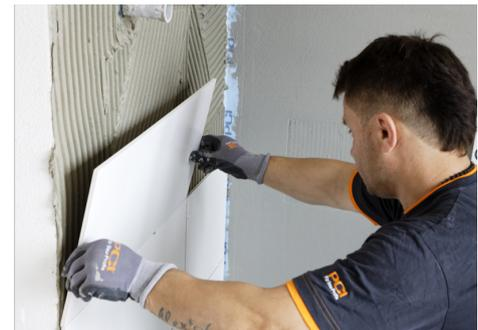
Avec PCI FT Extra, les carreaux peuvent être posés en toute sécurité sur l'imperméabilisation collée PCI Lastogum.
