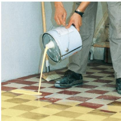
Bien remuer et verser PCI Gisogrund 303 uniformément sur le support.
