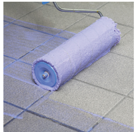
PCI Gisogrund 404 avec la teinte de contrôle violette permet une adhérence élevée des masses d'égalisation et des matériaux de pose sur le support respectif.
