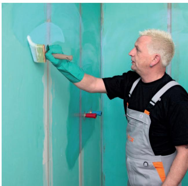
1. Couche de fond : sur supports minéraux absorbants ou plâtre et plaques de plâtre cartonné, appliquer une couche de fond de PCI Gisogrund.
