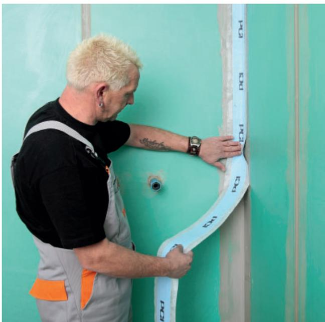
3. Coller la bande PCI Pectape 120 avec PCI Lastogum (gris) dans les joints d'angle et de liaison sol/mur.
