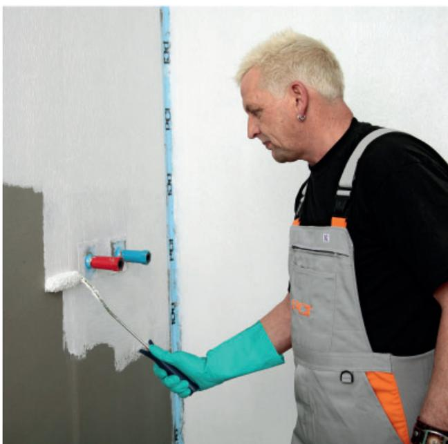
5. Après un temps de séchage d'env. 1 heure, appliquer la deuxième couche de PCI Lastogum (blanc). Éviter la transparence de la première couche de PCI Lastogum (blanc). Si nécessaire, refaire une application.
