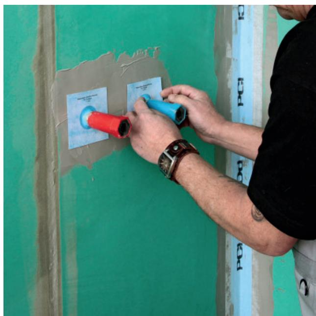
2. Procéder à l'imperméabilisation des passages de tuyaux par la mise en place de manchettes de sécurité et d'imperméabilisation PCI Pécitape 10 x 10 et coller l'entoilage avec PCI Lastogum (gris).
