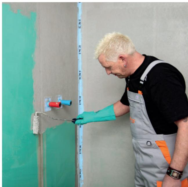
4. Appliquer la première couche avec PCI Lastogum (gris) non dilué de façon uniforme et continue sur le support.
