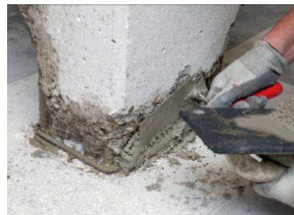
PCI Nanocret R4 PCC, mortier de réparation onctueux à haute résistance
