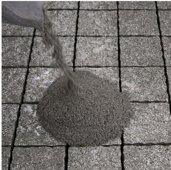
Découper le sac sous vide et verser le matériau frais sur la surface humide du revêtement.
