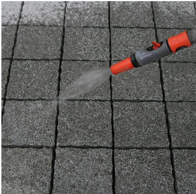
Humidifier abondamment la surface de la pierre et les flancs de joints avant le jointoiment.
