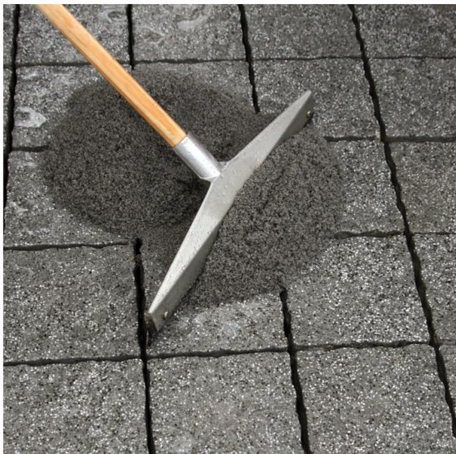
Introduire PCI Pavifix 1K Extra sous pression dans les joints à l'aide d'un poussoir en caoutchouc.
