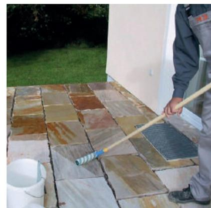
L'application de PCI Pavifix V avant le jointoiment facilite l'élimination des résidus sur la surface de la pierre et maintient son apparence naturelle.
