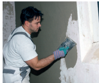
La mise en œuvre de PCI Pericret est très souple – en couches de 3 à 50 mm d'épaisseur.
