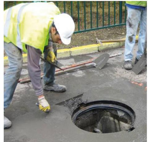
Insertion d'un anneau de chambre avec PCI Repafast Tixo
