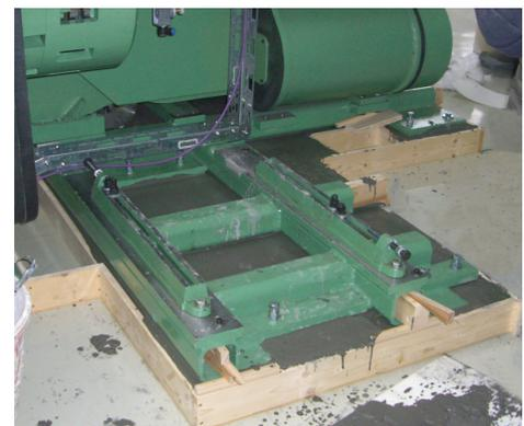
PCI Repaflow permet de réaliser des assemblages par transfert de force.
