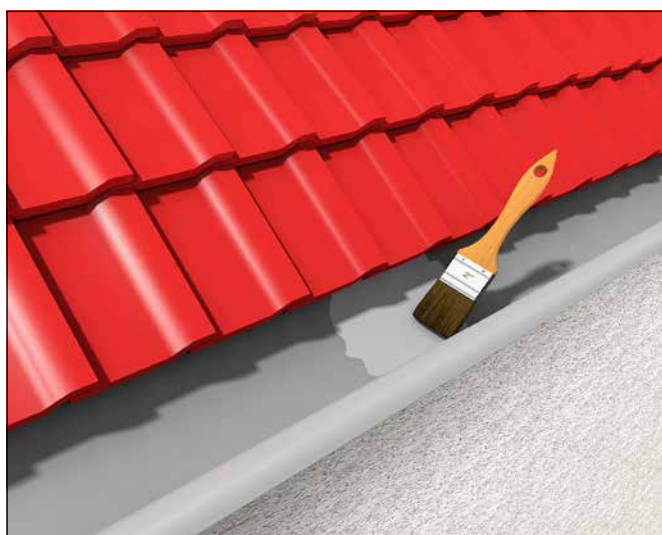
3 Etanchéité et réparation des chéneaux
