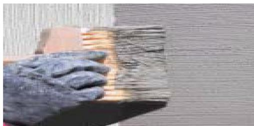
Pour faciliter la pénétration de **MAXSEAL®** dans les pores et les cavités, utiliser un **pinceau** ou une **brosse** en nylon dur **DRIZORO** en appuyant légèrement sur le support.
