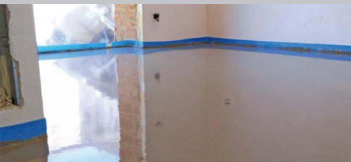
Appliquer en une seule passe continue pour éviter les raccords, si nécessaire égaliser en passant un débulleur ou un râtelier cranté.
