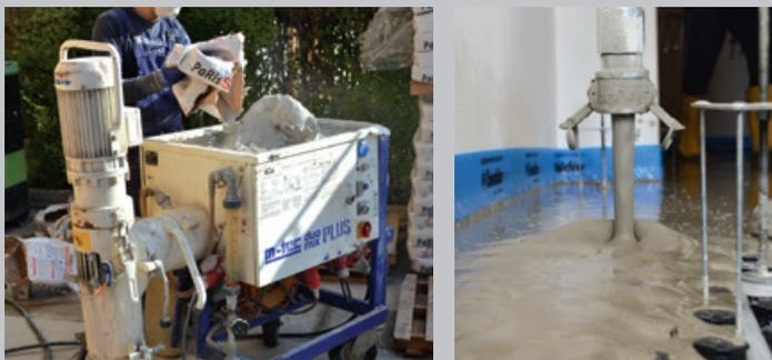
**GÂCHER À RAISON D'ENVIRON 4 - 4,5 LITRES D'EAU PAR SAC - CONSISTANCE AUTONIVELANTE**
