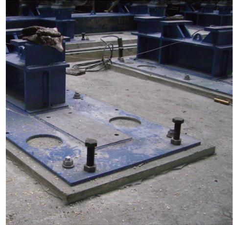
PCI Repaflow assure une liaison sans reprise, exempte de fissures et vides, qui permet une marche régulière des machines et dès lors un travail plus précis et une moindre usure des machines.
