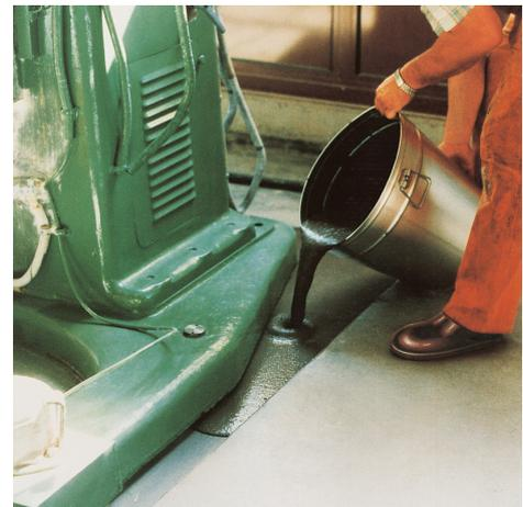
PCI Repaflow est coulant et remplit par gravité les espaces creux horizontaux.
