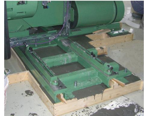
PCI Repaflow permet de réaliser des scellements par transfert de force.
