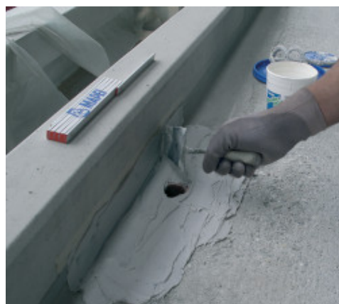
Couverture finale avec Adesilex PG4
