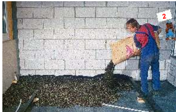
Schütten und verteilen, Mindesthöhe 20 mm.
