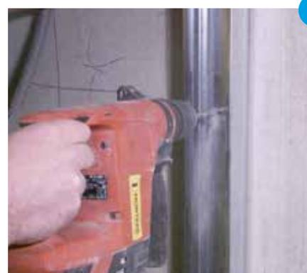
3. Fixer le profilé, puis fixer la plaque de plâtre sur le joint de 3-5 mm au profilé.
