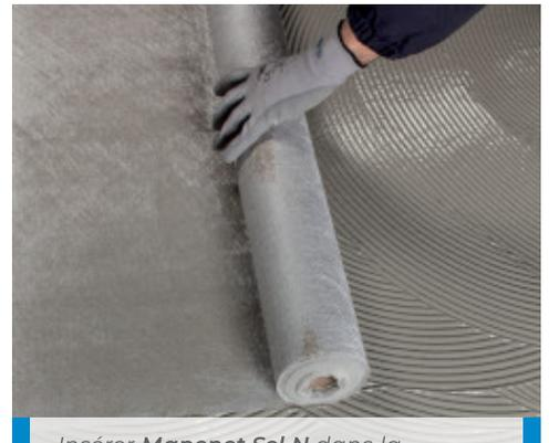
Insérer **Mapenet Sel N** dans la première couche de **Mapelastic Turbo** encore fraîche
