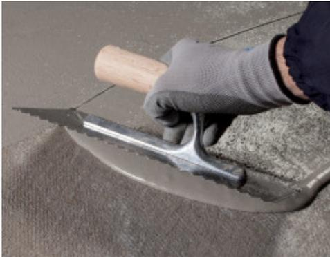
La seconde couche de **Mapelastic Turbo** sur la première couche renforcée avec **Mapetex Sel N**
