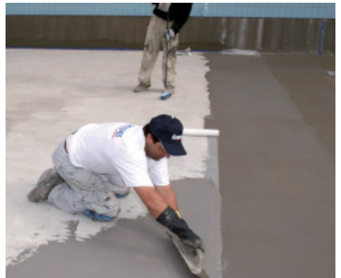
Imperméabilisation d'une piscine avec Mapelastix Zero
