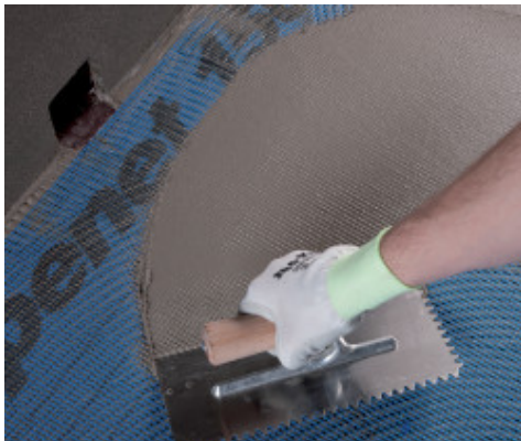
Application de Mapelastix Zero sur Mapenet 150
