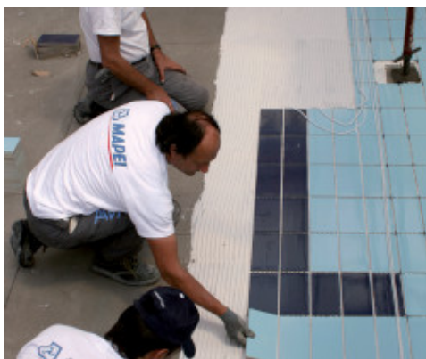
Pose de carrelage céramique sur Mapelastix Zero dans une piscine
