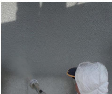
Exemple d'application de Mapelastix Zero par projection sur un viaduc
