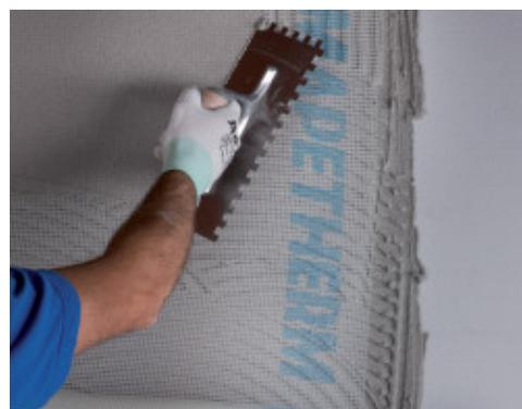
Application d'une couche de ragréage renforcé en y enfonçant Mapetherm Net
