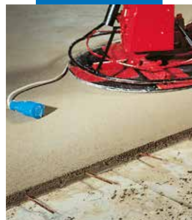
Finition de la chape avec un hélicoptère à béton
