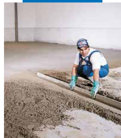
Préparation de bandes de nivellement
