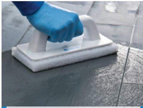
Nettoyage des joints avec un pad Scotch- Brite® (quand le produit est partiellement durci)
