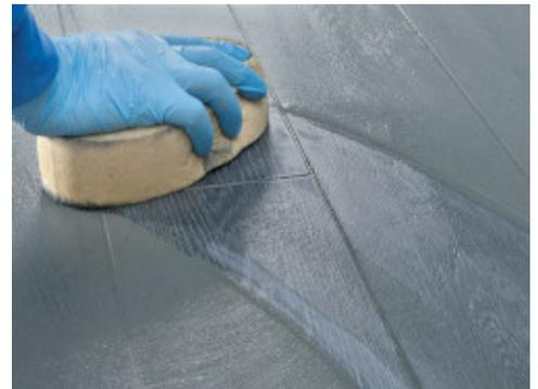
Nettoyage et finition des joints avec une éponge en cellulose dure
