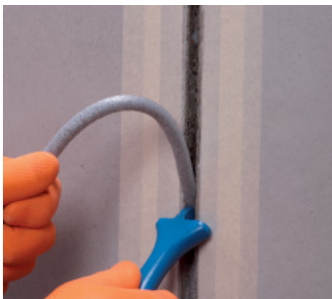
Insertion du fond de joint MAPEFOAM
