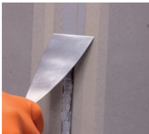
Lissage de Mapeflex PU40
